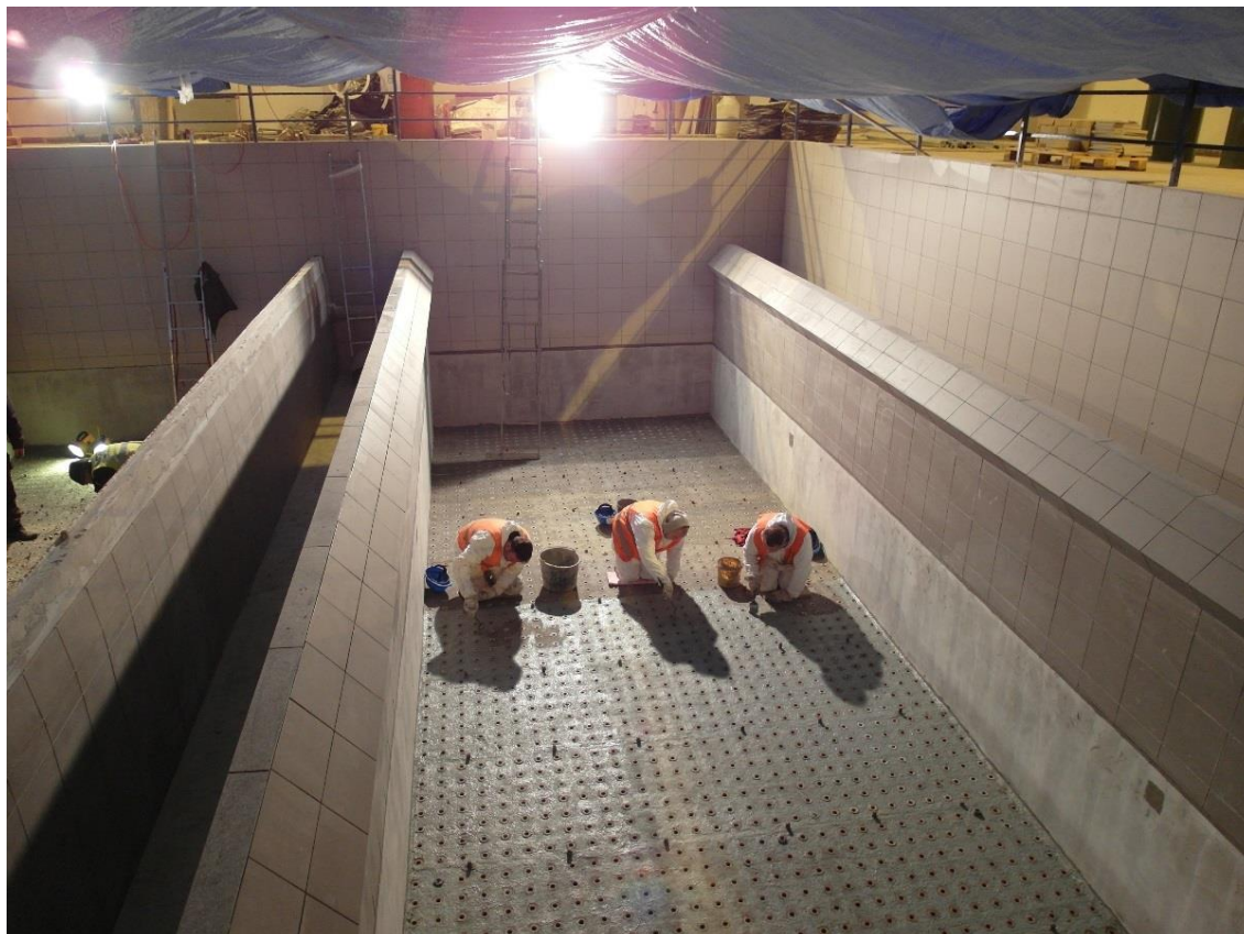
Sanace pískových filtrů včetně výměny filtračních trysek – 10 filtrů
