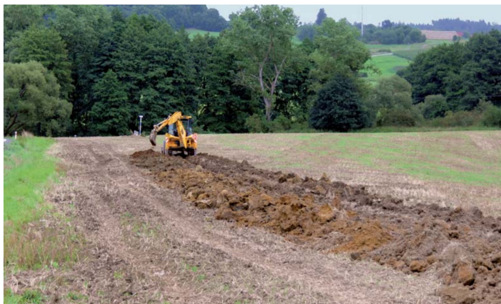
Práce na rekonstrukci vodovodního řadu mezi Olešníkem a Chlumcem.
