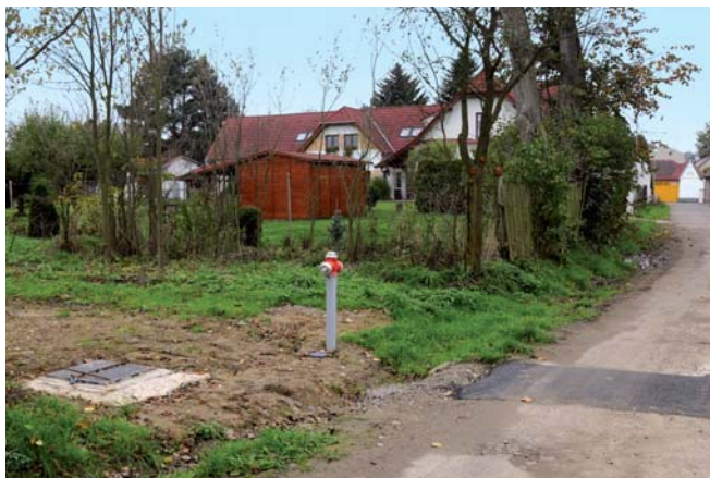
Nedávné zemní práce připomíná už jen veřejný výtokový stojan.
