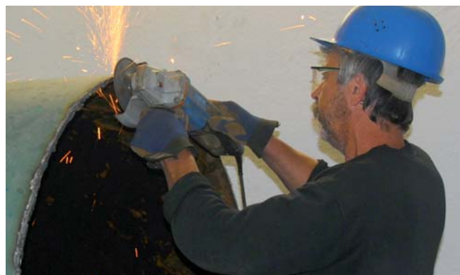
Provozní montér JVS Karel Kohout připravuje potrubí ke svaření.
