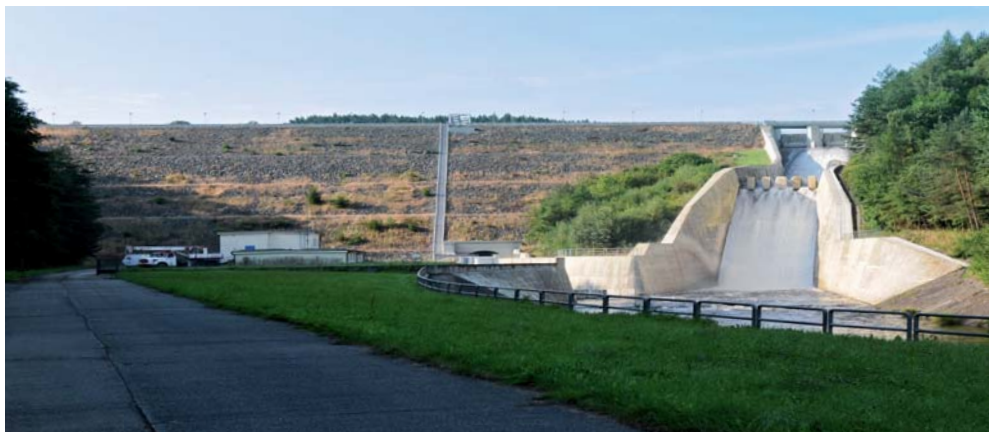
Přehrada Římov s předávacím objektem Jihočeského vodárenského svazu.
