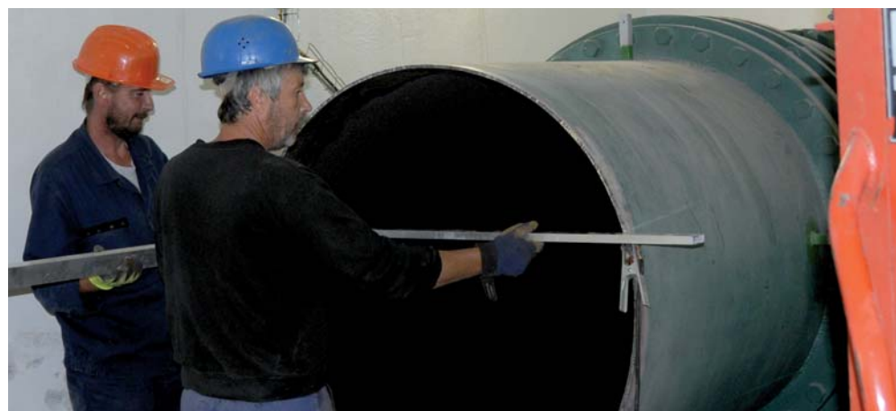
Spolu s kolegou Petrem Beranem zaměřují potrubí DN 1200.
