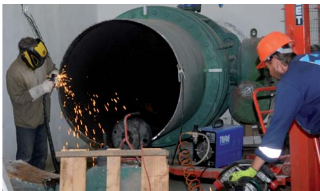
Úprava potrubí pro vložení průtokoměru.
