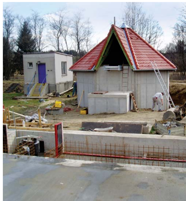
Dolní Dvořiště (rekonstrukce ČOV)
