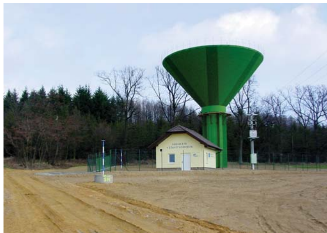
Sedlice II věžový vodojem
