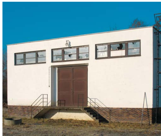
Vidov (čerpací stanice - nouzové zásobení ÚV Plav)
