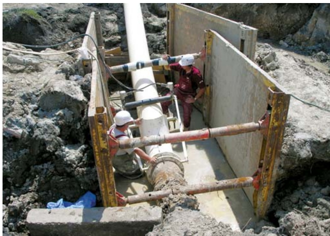
Zajištění standardů EU - zasouvání textilního rukávce
