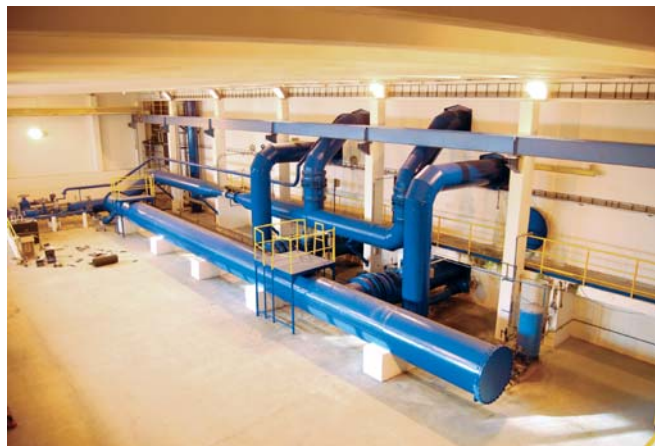
Vodojem Čekanice vnitřek
