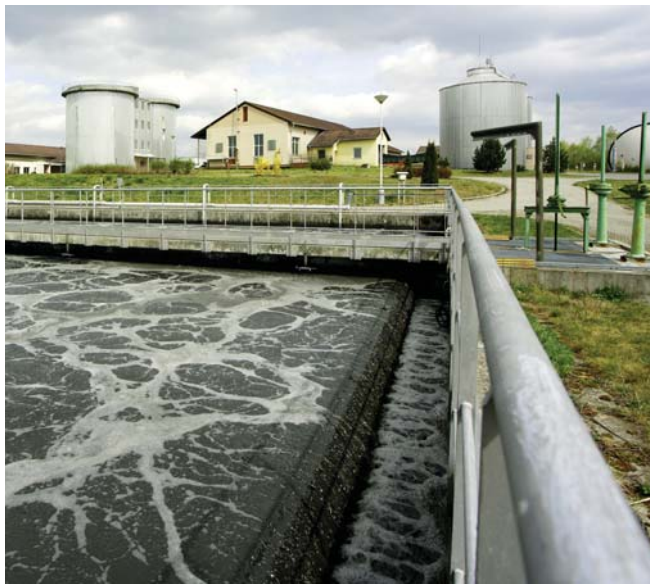
Rekonstrukce ČOV Jindřichův Hradec
