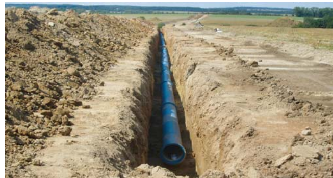
Zásobení Lomnicka - pokládání potrubí
