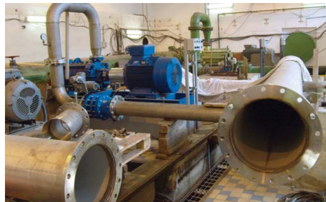
Rekonstrukce čerpací stanice Těšovice
