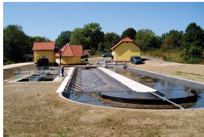
Dolní Dvořiště (rekonstrukce ČOV, celkový pohled)
