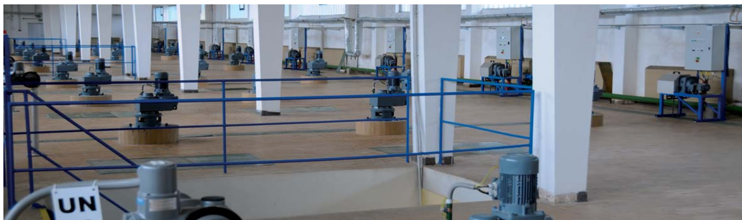
Celkový pohled na halu usazovacích nádrží.
