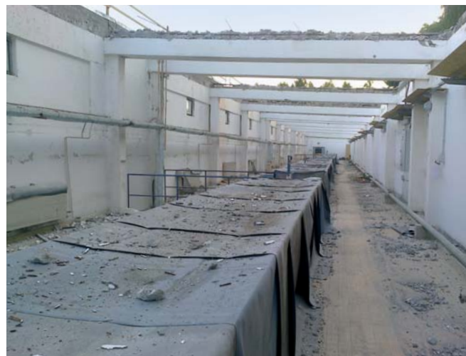
Součástí rekonstrukce byla i náročná oprava betonových stropů.
