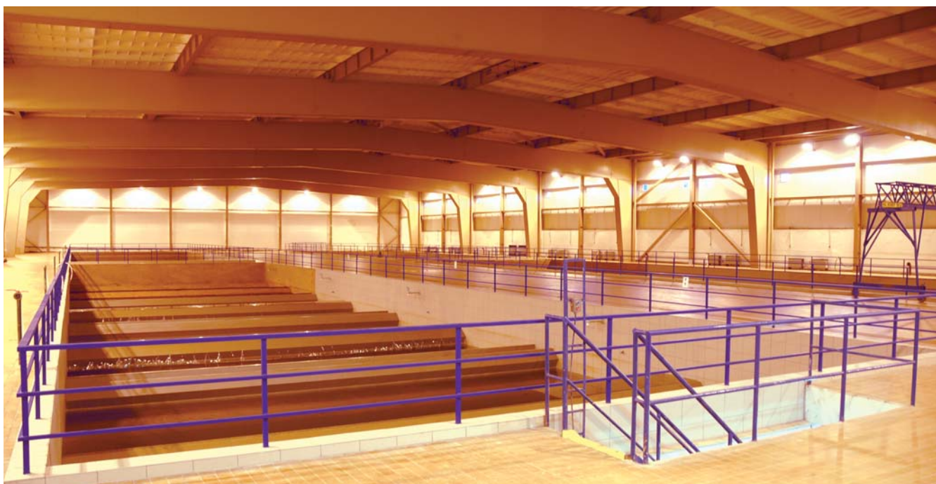
Rekonstrukcí prošlo 10 ze 14 pískových filtrů.
