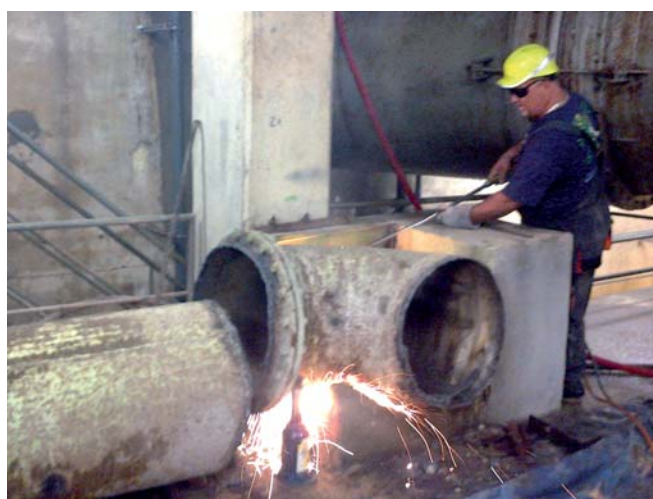
Demontáž potrubí prací vody.
