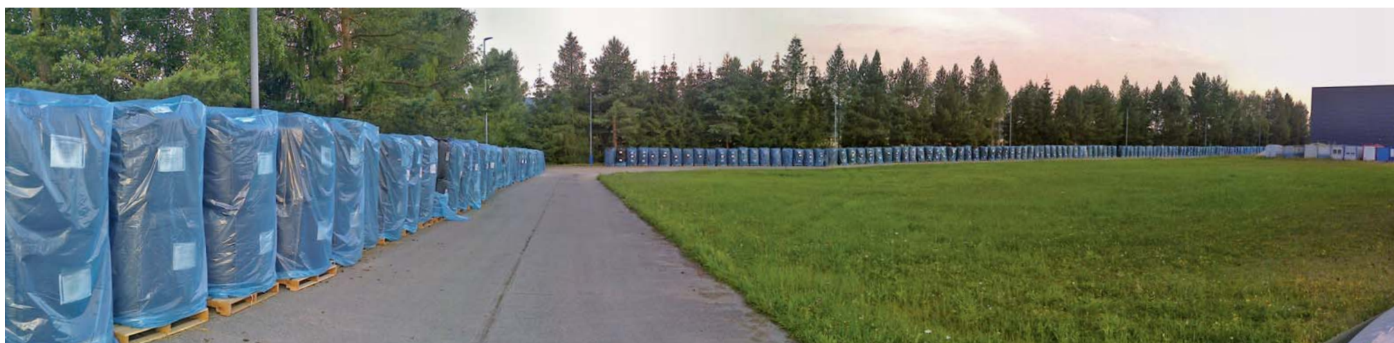
K uložení do GAU filtrů bylo připraveno 720 balíků granulovaného uhlí.
