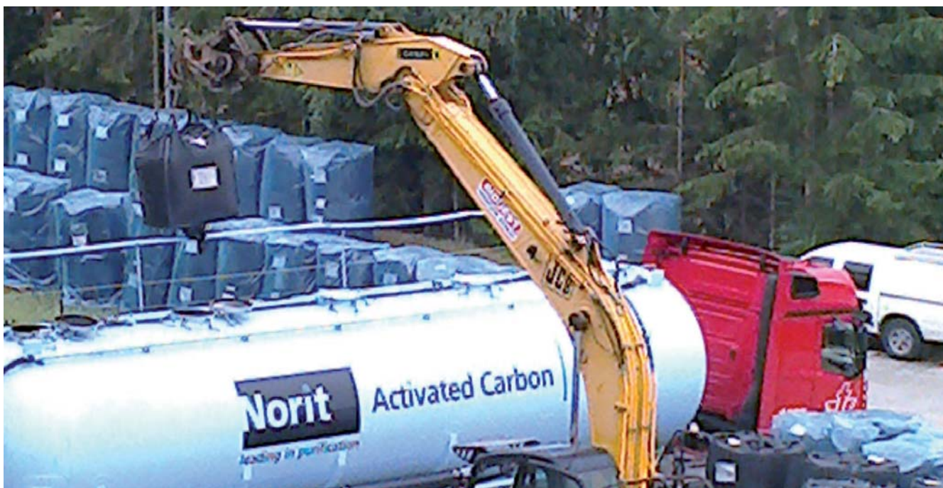
Nakládání granulovaného uhlí z vaků do cisteren, z nichž putovaly do GAU filtrů.
