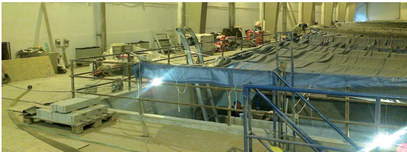
Provizorní zakrytí pískových filtrů během stavby.
