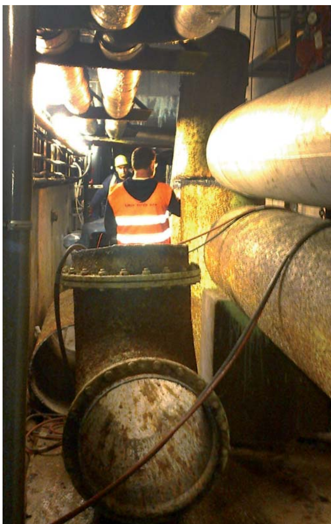
Demontáž potrubí prací vody.
