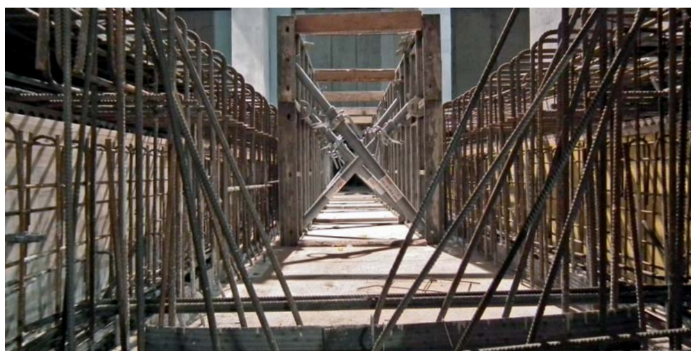
Armování betonových nádrží GAU filtrů.
