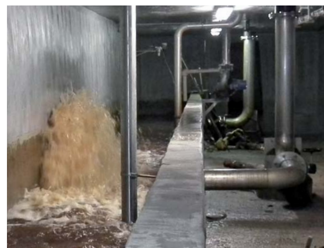
Pohled na odkalovací kanál usazovacích nádrží po rekonstrukci.
