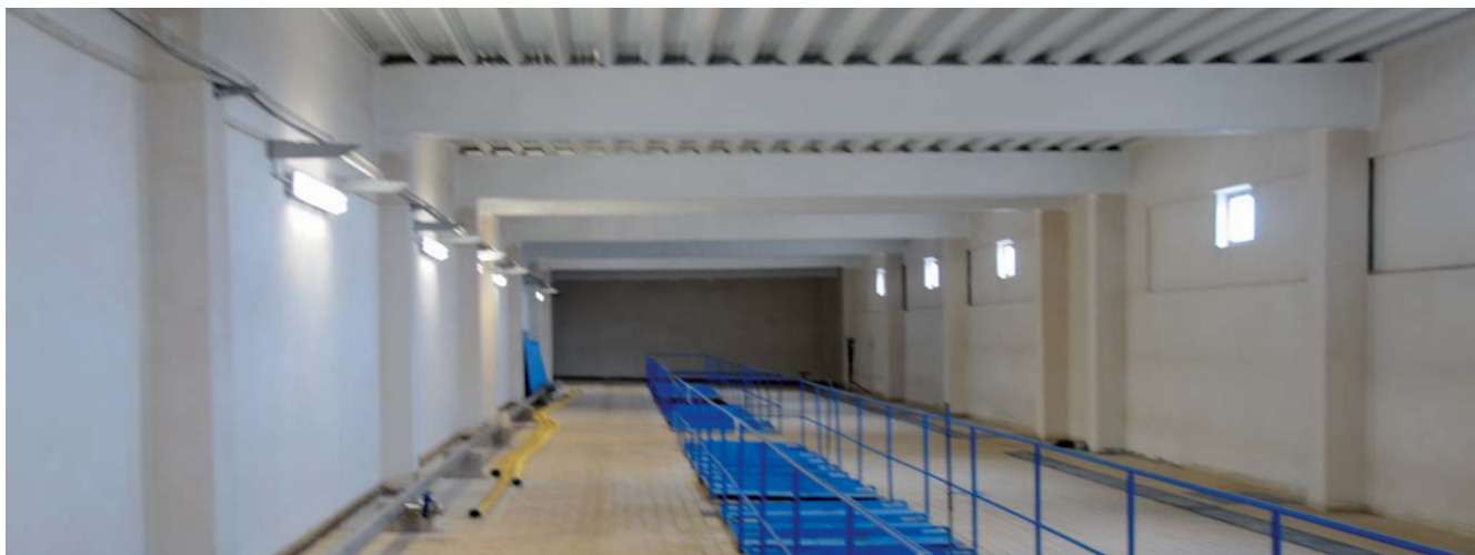
Rekonstrukce stropu budovy přelivné hrany.
