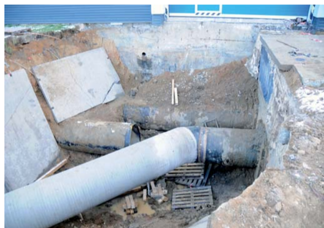
Krátká, ale významná přeložka hlavního řadu v areálu úpravy Plav, jímž odtéká voda do vodojemu Včelná a dál do kraje. Původní řad byl položen tak nevhodně, že v případě poruchy by bylo velmi obtížné ho opravit. Proto byl loni přeložen do nové trasy, aniž to zákazníci na zásobování poznali.
