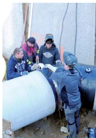
Krátká, ale významná přeložka hlavního řadu v areálu úpravy Plav, jímž odtéká voda do vodojemu Včelná a dál do kraje. Původní řad byl položen tak nevhodně, že v případě poruchy by bylo velmi obtížné ho opravit. Proto byl loni přeložen do nové trasy, aniž to zákazníci na zásobování poznali.
