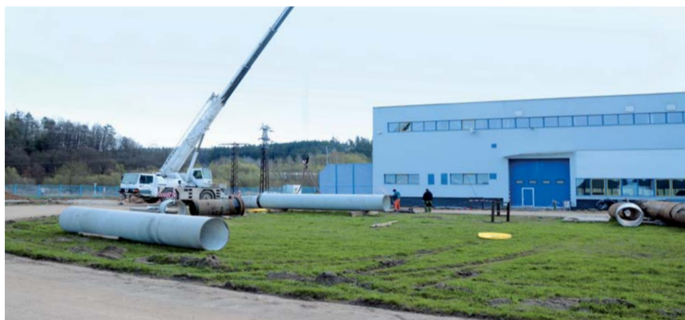
Krátká, ale významná přeložka hlavního řadu v areálu úpravy Plav, jímž odtéká voda do vodojemu Včelná a dál do kraje. Původní řad byl položen tak nevhodně, že v případě poruchy by bylo velmi obtížné ho opravit. Proto byl loni přeložen do nové trasy, aniž to zákazníci na zásobování poznali.
