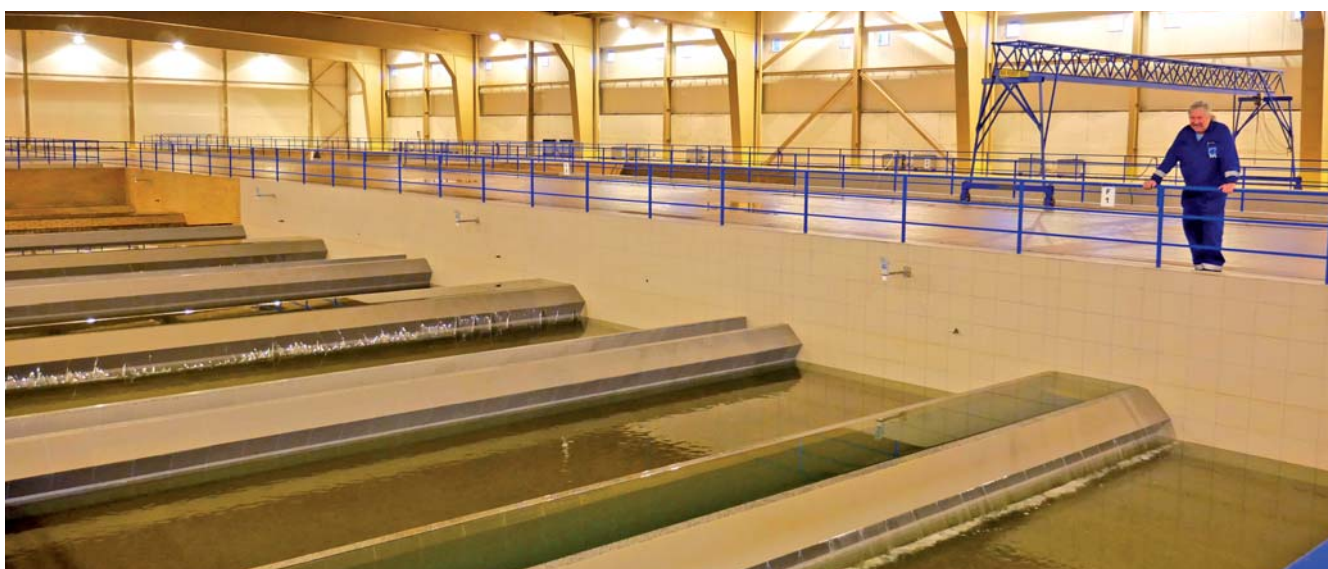
Pískové filtry – naplní 14 filtrů je křemičitý písek. Plocha jednoho filtru je 78 m 2 , výška náplně 135 cm.
