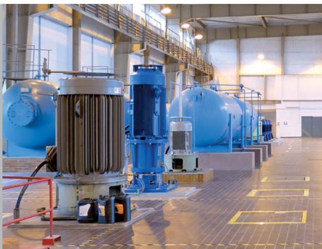
Čerpací stanice úpravny vody Plav – nadzemní podlaží.
