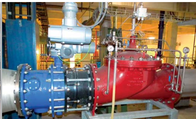
Automatický regulační ventil o průměru 400 mm na praní filtrů s náplní z aktivního uhlí a průtokem až 600 l/s.
