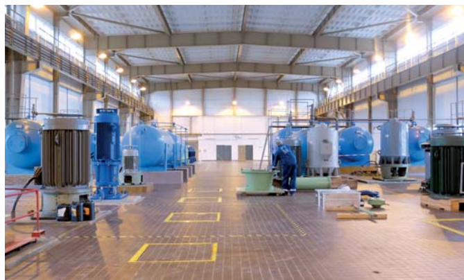
Nadzemní podlaží čerpací stanice.
