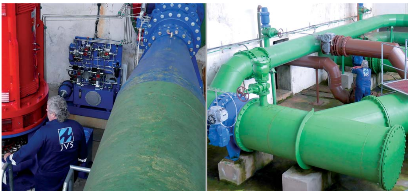
Nátok surové vody na úpravnu Plav – elektrárna o výkonu 280 kWh.
