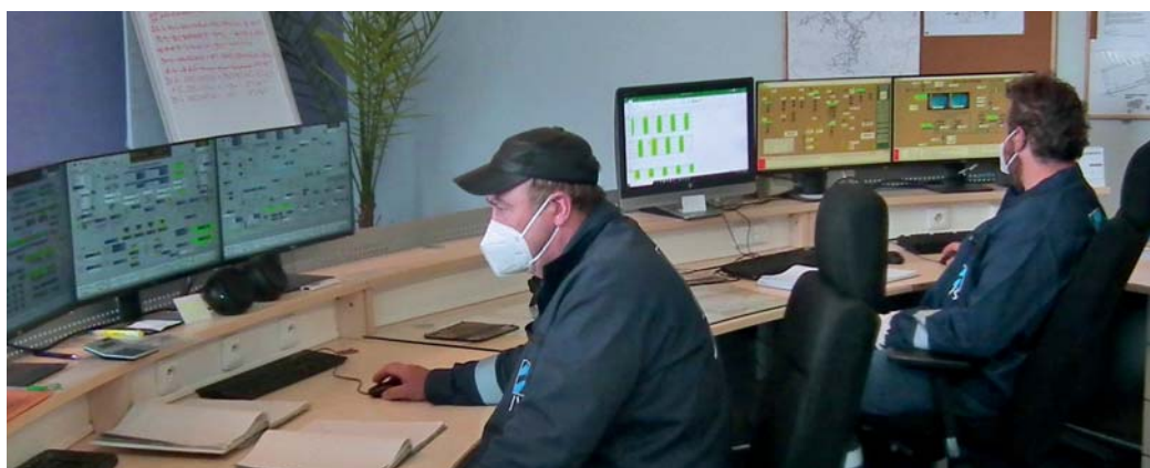
V době nouzového stavu má na velín úpravní vody Plav přístup pouze omezený počet pracovníků.
