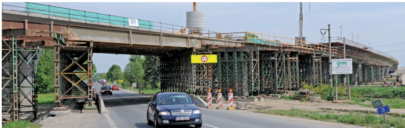
Jedním z míst, kde se musí přeložit trasa vodárenské soustavy, je i okolí Veselí nad Lužnicí, kolem něhož vede trasa dálnice i s novým mostem.
